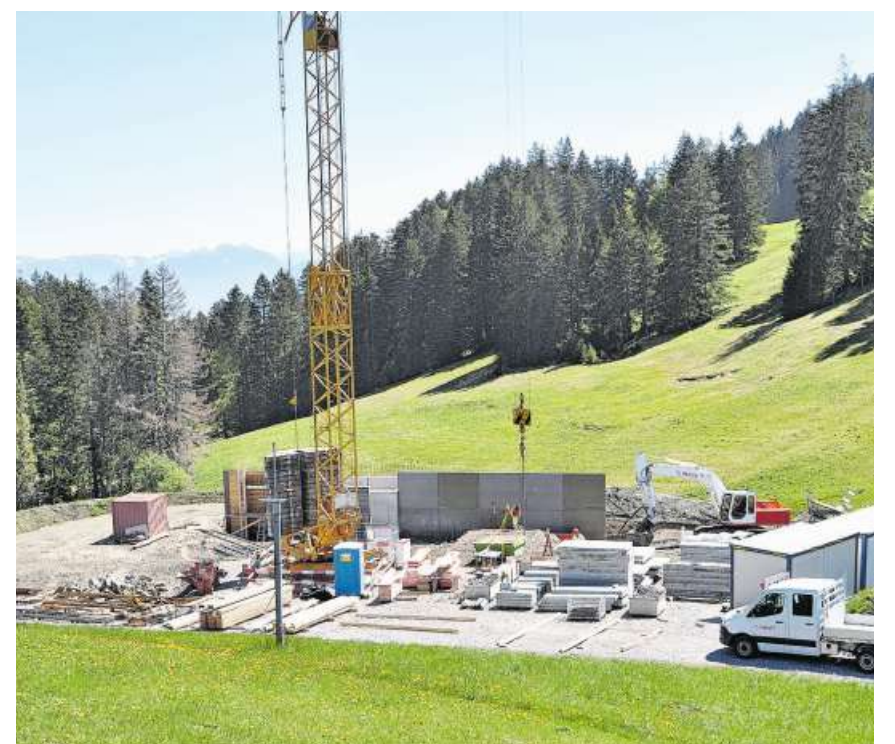
Als eines der ersten Elemente der Sesselbahn wird die Talstation erstellt.
