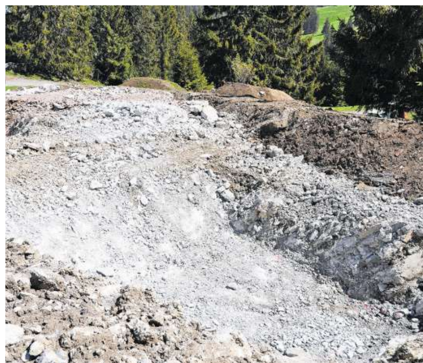
Wo heute Steine liegen, steht im Herbst die Bergstation der Sesselbahn.
