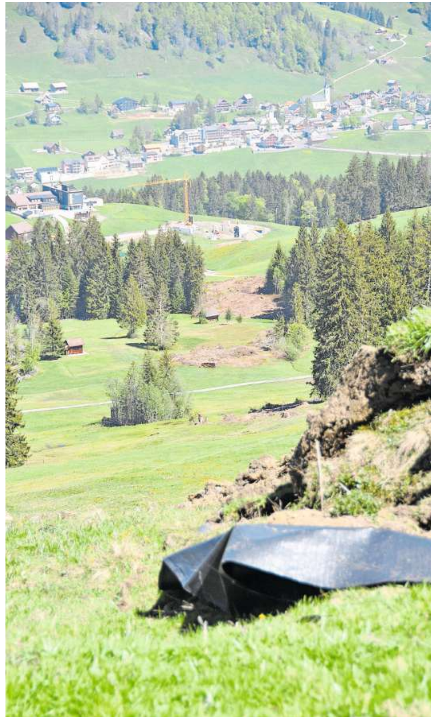
Seit Mitte April wird in Wildhaus an der neuen Familienbahn, die vom Oberdorf auf die Freienalp führt, gebaut.
