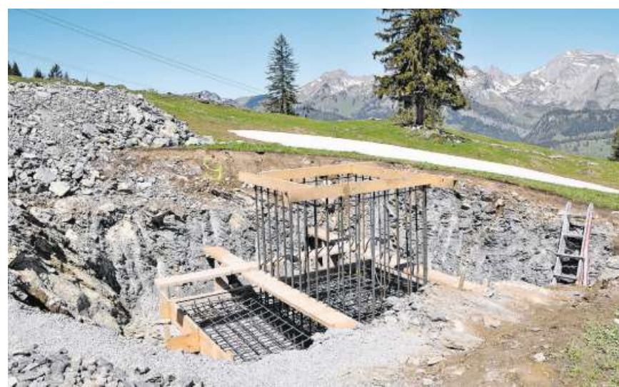
Bereits laufen die Vorbereitungsarbeiten für den Bau der Stützen der Sesselbahn.
