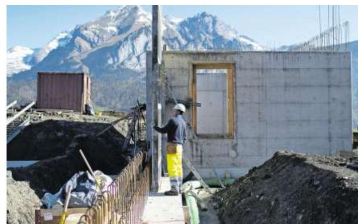
Baustelle der neuen 6er-Sesselsbahn Oberdorf-Freienalp der Bergbahnen Wildhaus. Bild: ky/Gian Ehrenzeller
