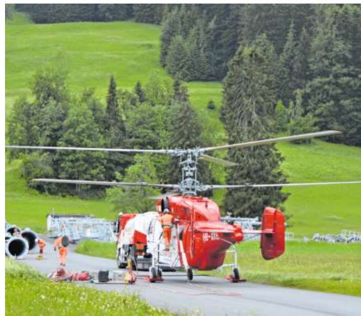
Der Schwerlastenhelikopter wird vor dem Einsatz aufgetankt.
