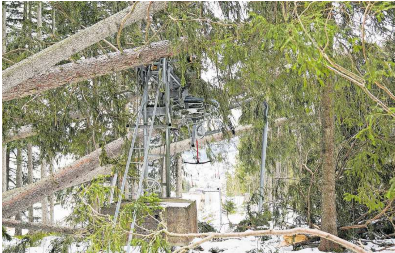
Der Orkan Sabine zerstörte den Skilift Oberdorf in Wildhaus.
