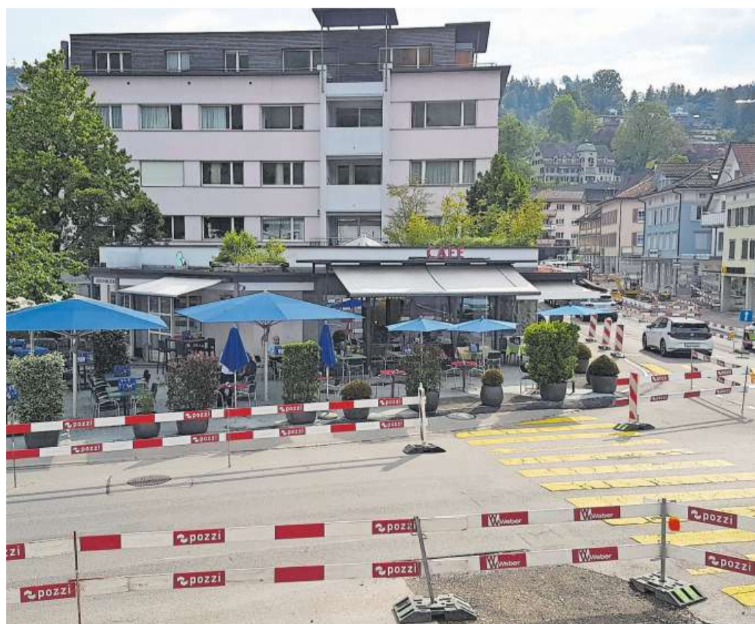
Die Gemeinde Wattwil lädt am 26. Juni zu einer Baustellenführung ein.
