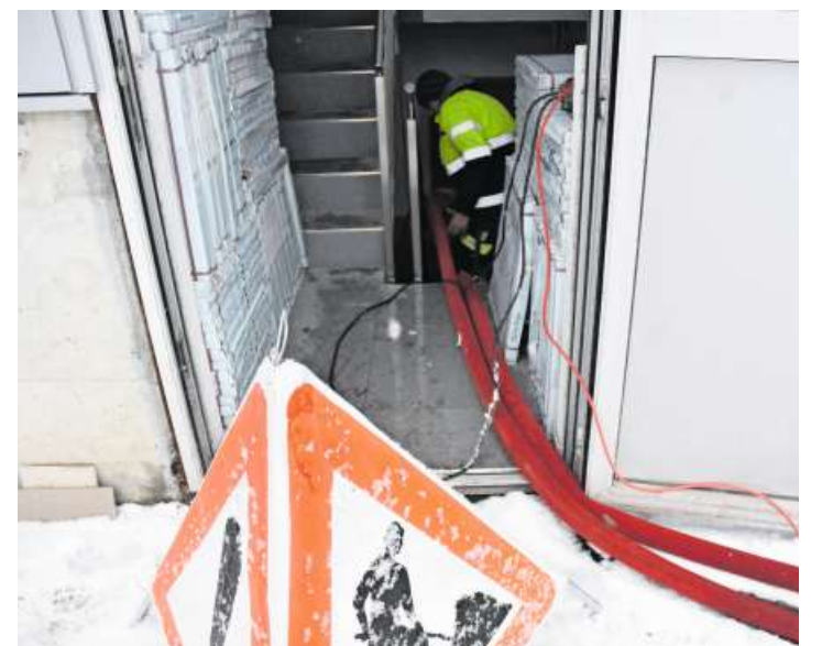
Mitarbeiter des Elektrizitätswerks Buchs setzen im Keller der Mühle Senn Wasserpumpen ein.
