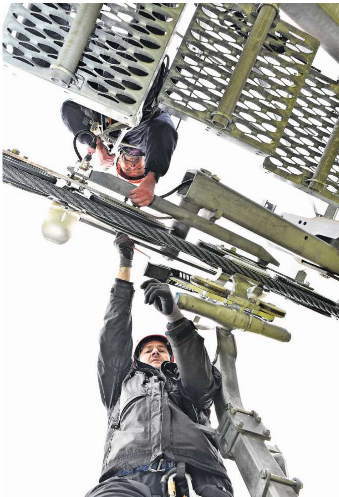
Schwindelfrei muss man sein, um eine Rolle der Seilbahn auszuwechseln.
