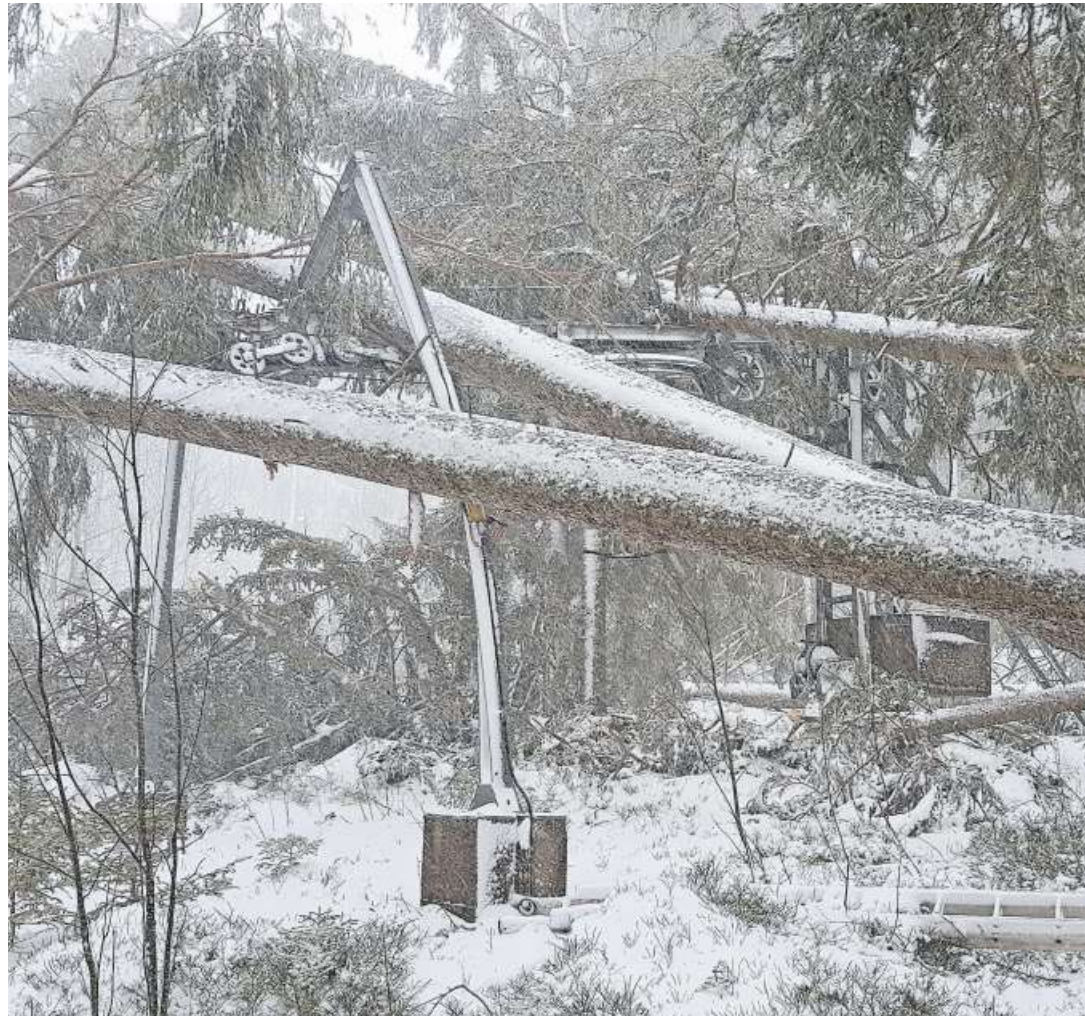
Der Sturm Sabine bescherte dem Wildhauser Skilift Oberdorf aus den 1960er-Jahren ein vorzeitiges Ende. Die Anlage kann nicht mehr repariert werden. Sie wäre im Frühling sowieso ersetzt worden. Bild: PD
